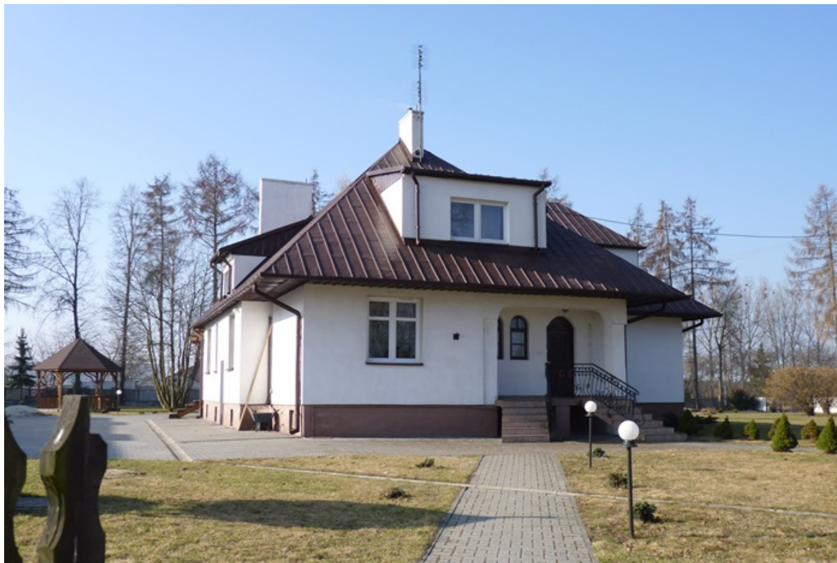
Widok od strony północnej(fot. marzec 2019 r.)
