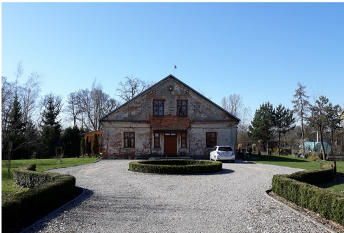
Widok od strony północnej( fot. marzec 2019 r.)
