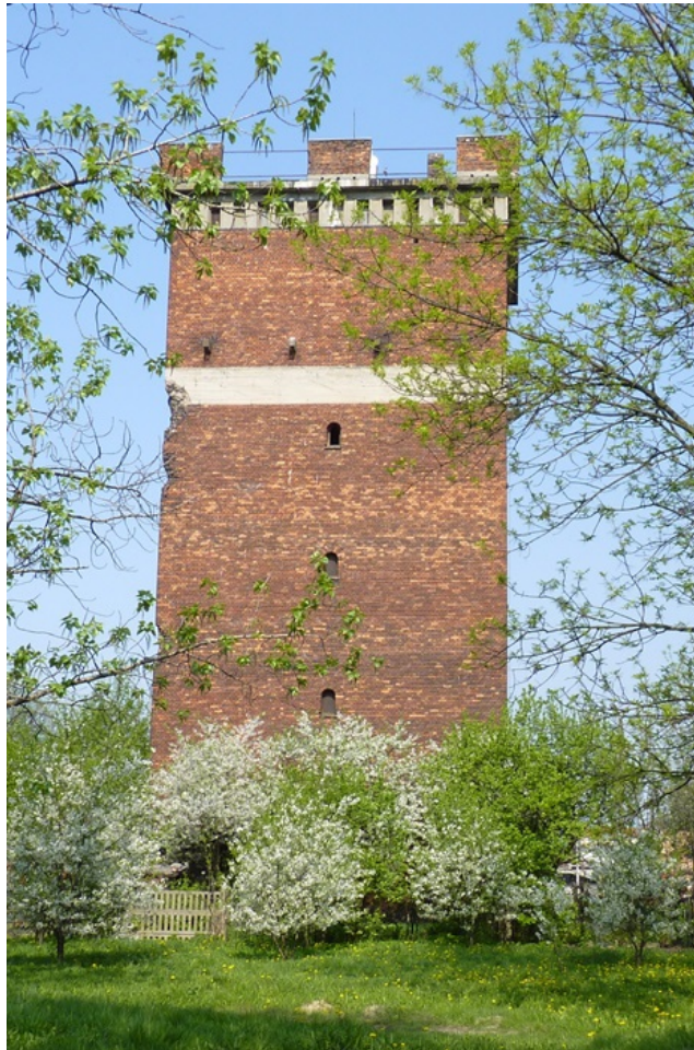
Widok od strony wschodniej( fot. kwiecień 2011 r.)
