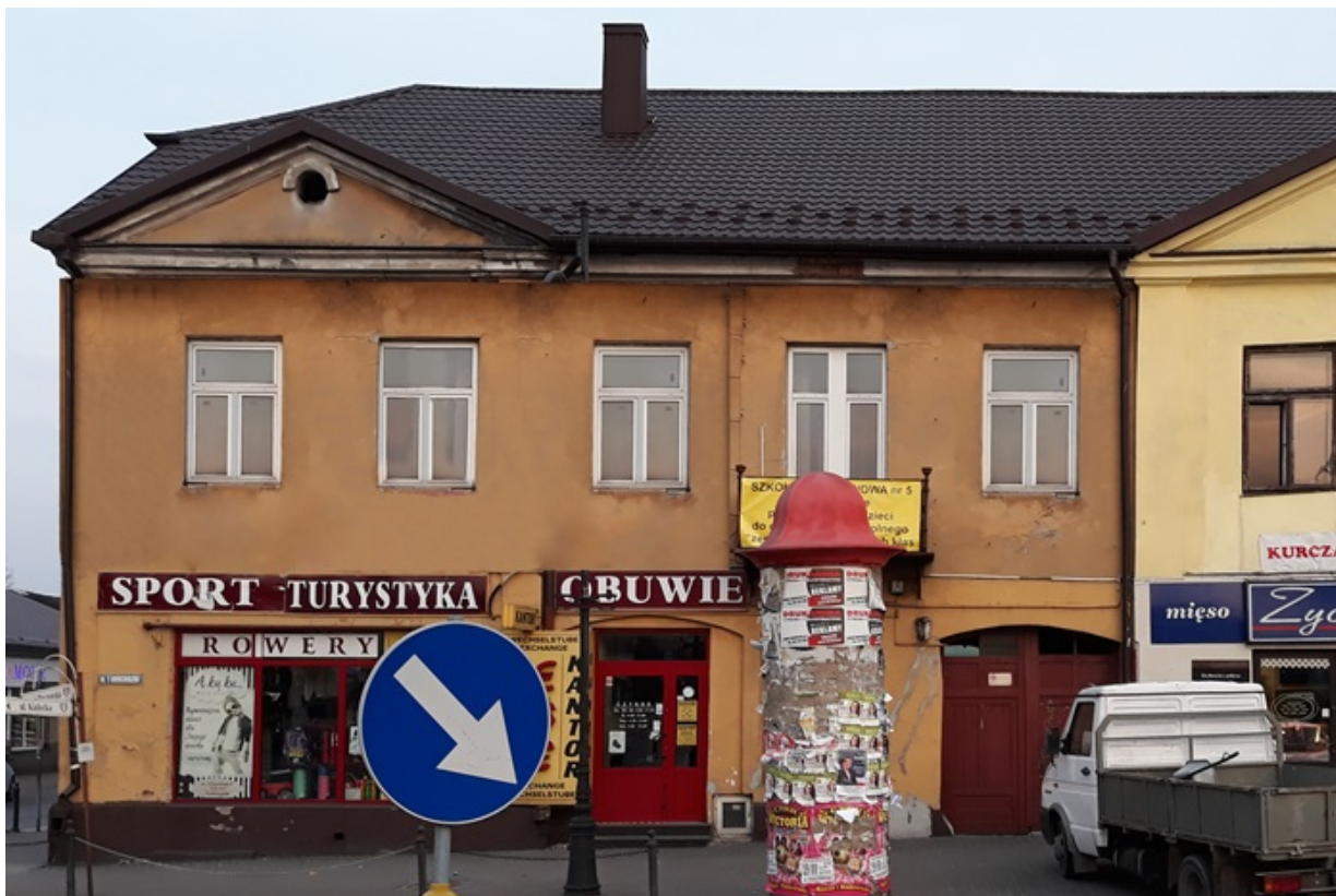
Widok od strony zachodniej( fot. kwiecień 2019 r.)
