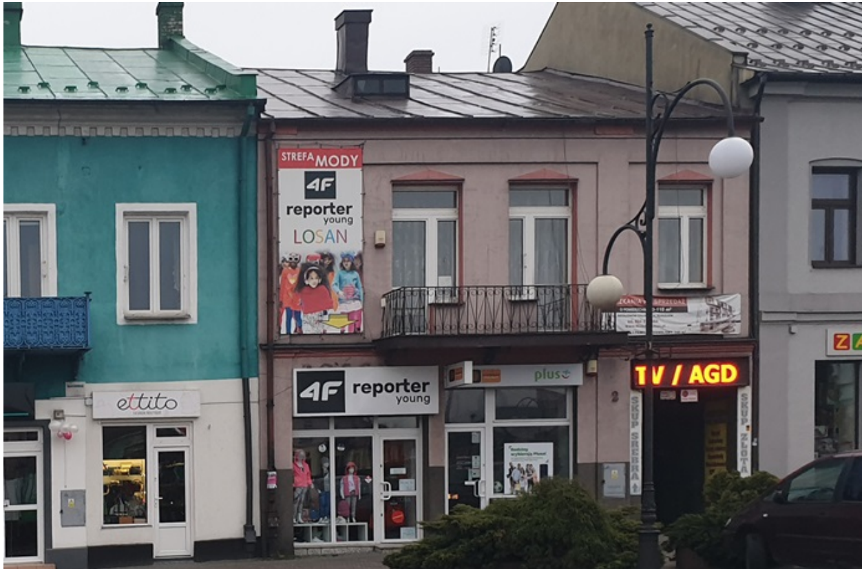
Widok od strony zachodniej( fot. kwiecień 2019 r.)
