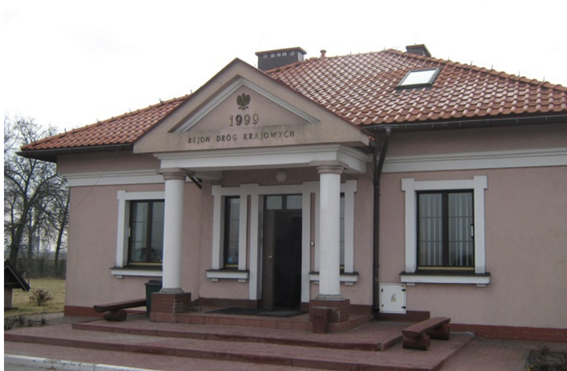
Widok od strony wschodniej (fot. kwiecień 2019 r.)
