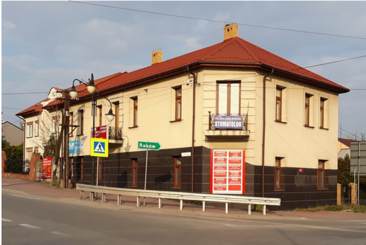
Widok od strony południowo-zachodniej (fot. kwiecień 2019 r.)
