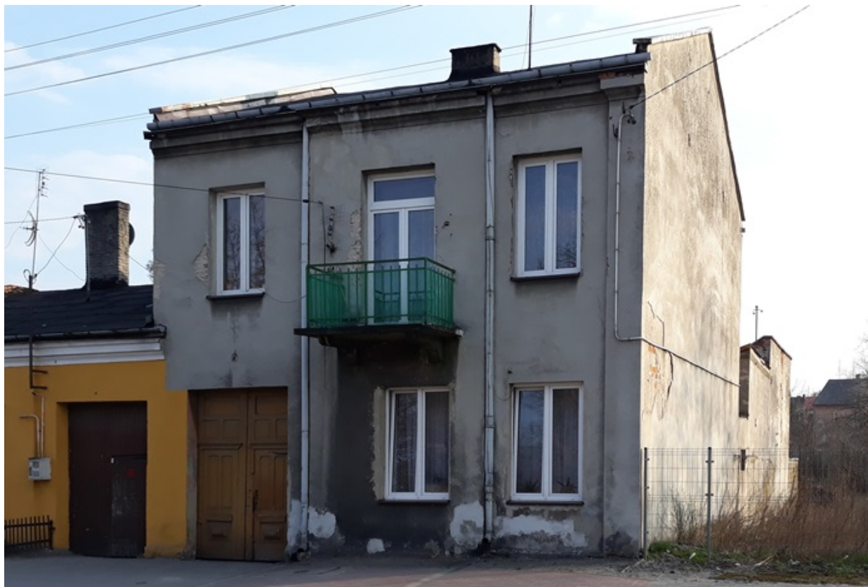
Widok od strony północnej ( fot. kwiecień 2019 r.)
