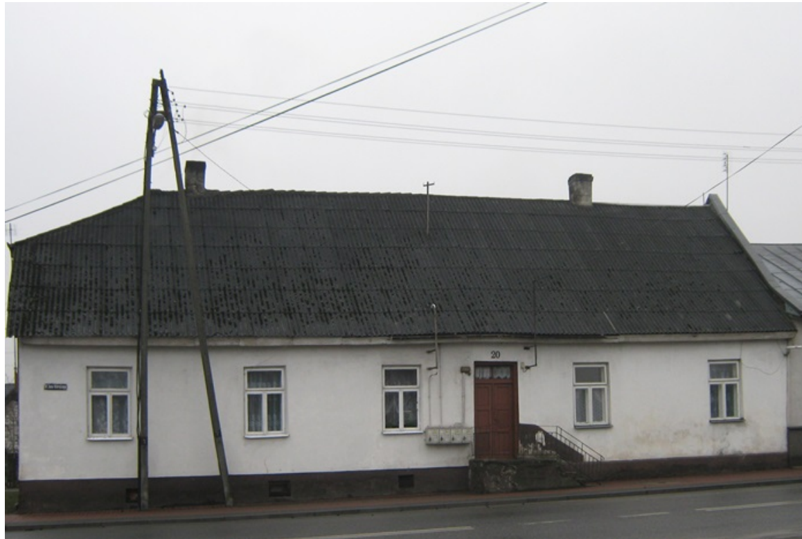
Widok od strony północnej ( fotografia: kwiecień 2019 r.)
