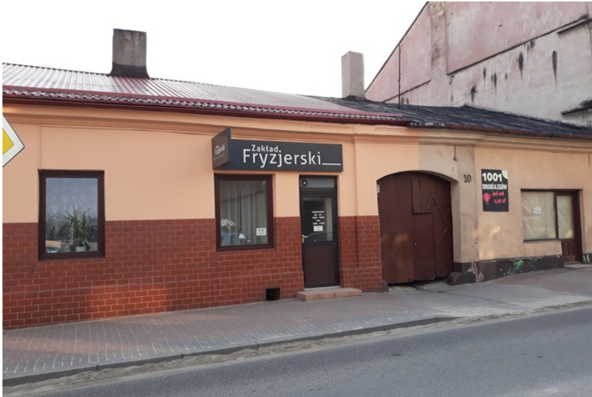
Widok od strony północnej ( fotografia marzec 2019 r.)
