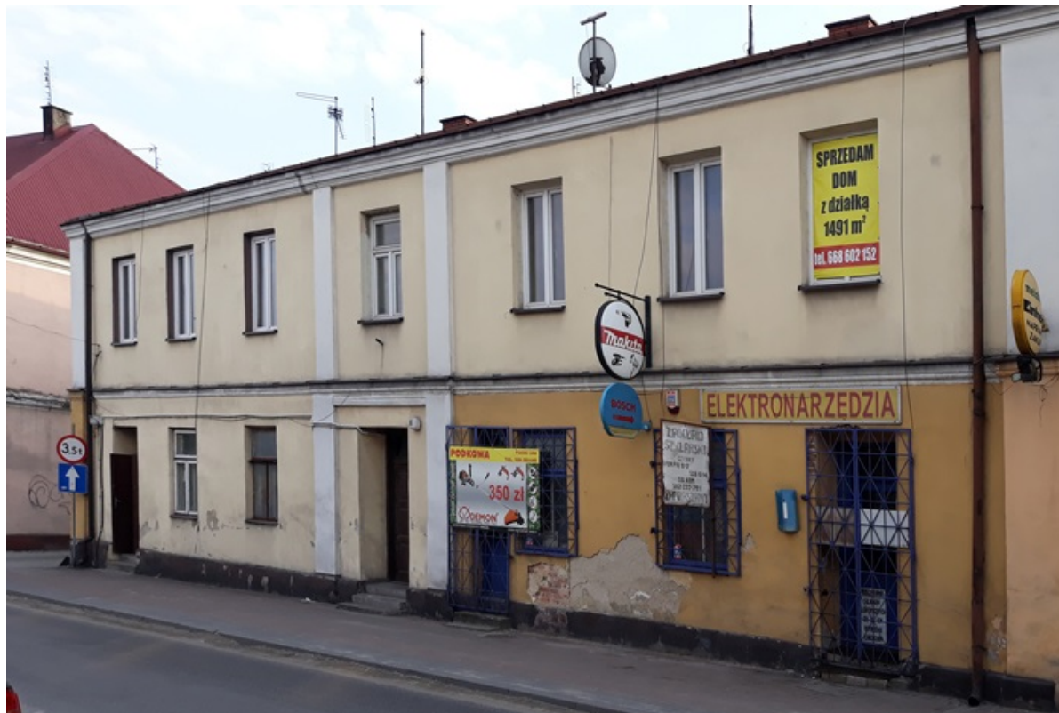
Widok od strony północno-zachodniej ( fotografia marzec 2019 r.)
